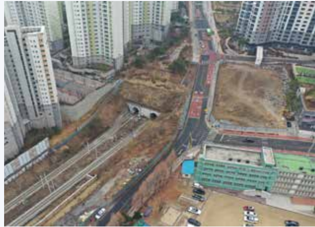
과선교 공사 전
